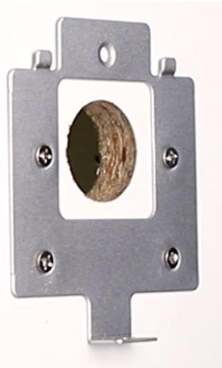
**Шаг 4:** прикрутите крепежную пластину к стене саморезами в намеченные отверстия. При необходимости, сперва просверлите отверстия под дюбели и забейте дюбели. Используйте крепёж из комплекта поставки.
