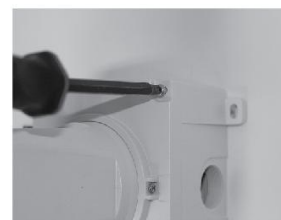
Затяните винты на кронштейне
