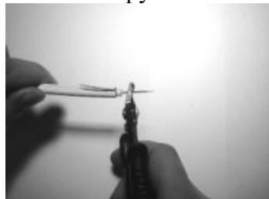
С помощью крестовой отвертки закрепите центральную жилу, оплетку проденьте в технологическое отверстие,
